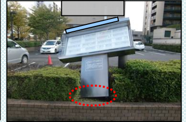
掲示板 (転倒の危険)
