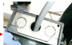
ケース1及びケース2とも配管配線導入部が防水立上り部にあるため、図-1のように雨水が屋内へ入り漏水する原因となります。
