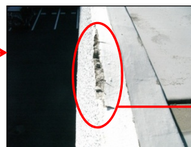
庇先端の破損
