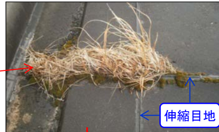
伸縮目地に雑草が生えている状況
