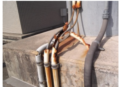
腐食した設備配管 【漏電や感電のおそれ】
