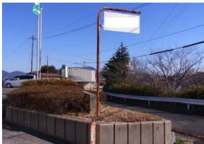
腐食した庁名板 【倒壊のおそれ】
