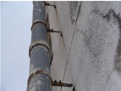
腐食した雨どいの取付金具 【配管の崩落のおそれ】
