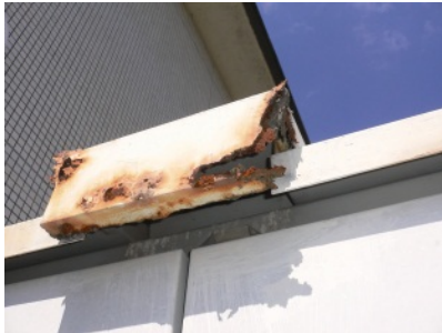
腐食した屋外キュービクルの屋根 【設備内部への漏水のおそれ】
