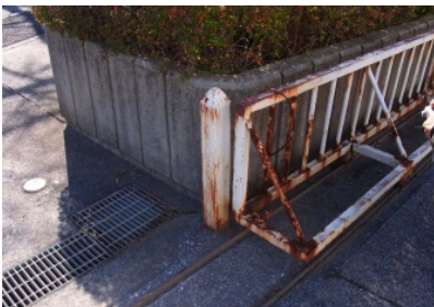
腐食した門扉 【開閉動作に支障をきたす】
