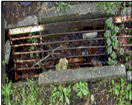
①敷地内の側溝、雨水枡の排水不良 【大雨時の敷地内外が冠水するおそれ】
