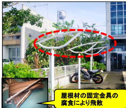
②駐輪場の屋根 【台風時の強風で、敷地外への飛散の おそれ】
