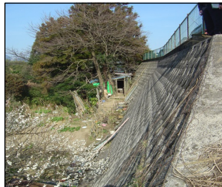
④擁壁：亀裂、損傷 【敷地外へ崩壊のおそれ】
