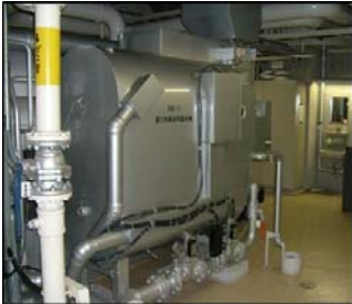
・熱源機（冷温水発生機） 空調に必要な冷水・温水を造り空気調和機へ供給する機器
