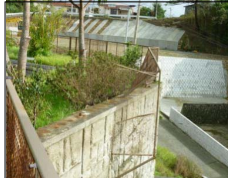
②フェンスの根本の腐食 【台風時の強風で破損、転倒のおそれ】
