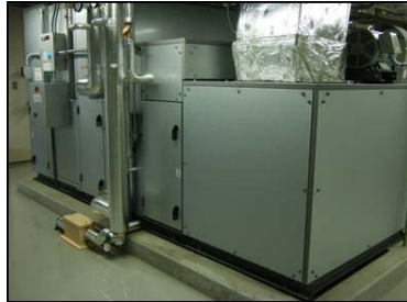
・空気調和機 熱源機から供給される冷水、温水等を用いて、空気の温度や湿度を調節して部屋へ供給する機器
