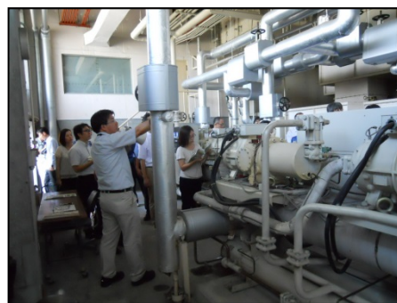
施設管理者の確認のポイント ～建物現地巡回による解説～
