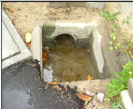
①敷地内の側溝、雨水枡の排水不良 【大雨時の敷地内外が冠水するおそれ】
