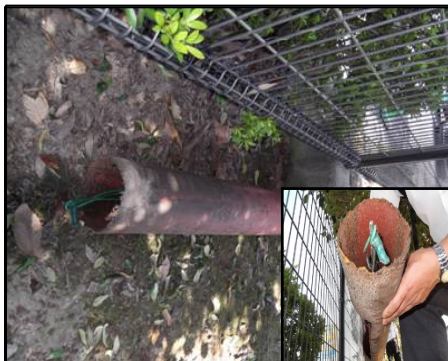
②外灯の根本の腐食 【台風時の強風で転倒、外灯転倒による 危害のおそれ】
