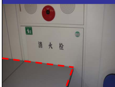
屋内消火栓の扉の前に机が置かれると...
