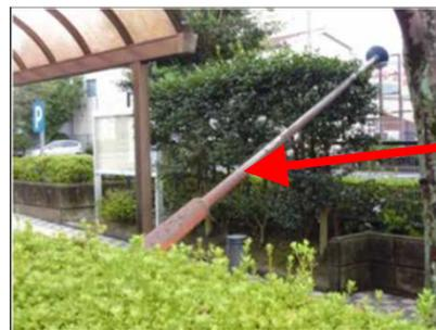
外灯ポールの倒壊。ポール柱脚の錆びは台風時転倒の恐れ。
