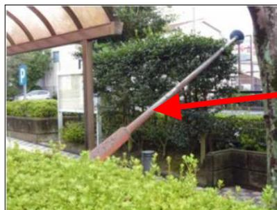
大風による外灯ポールの倒壊。ポール柱脚の錆びやがたつき等は台風時転倒につながります。
