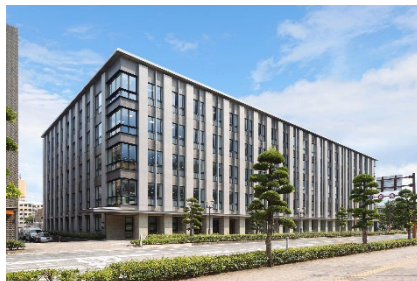
【鹿児島第三地方合同庁舎】 (令和5年8月30日完成)
