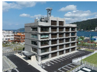
【名瀬第二地方合同庁舎】 (令和6年10月25日完成)
