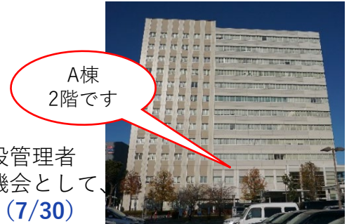
熊本合同庁舎A棟
