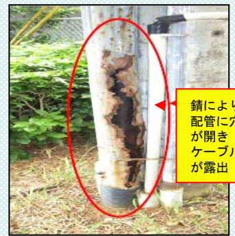
電力引込柱 (感電の危険)
