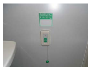
②非常用ボタン
