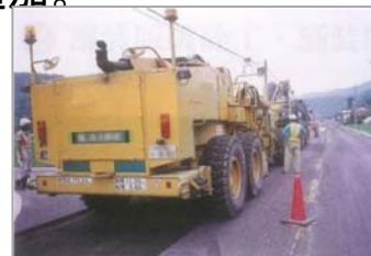
路面切削作業
