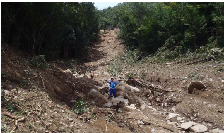
▲ 現地調査 (八木地区：危険度点検)
