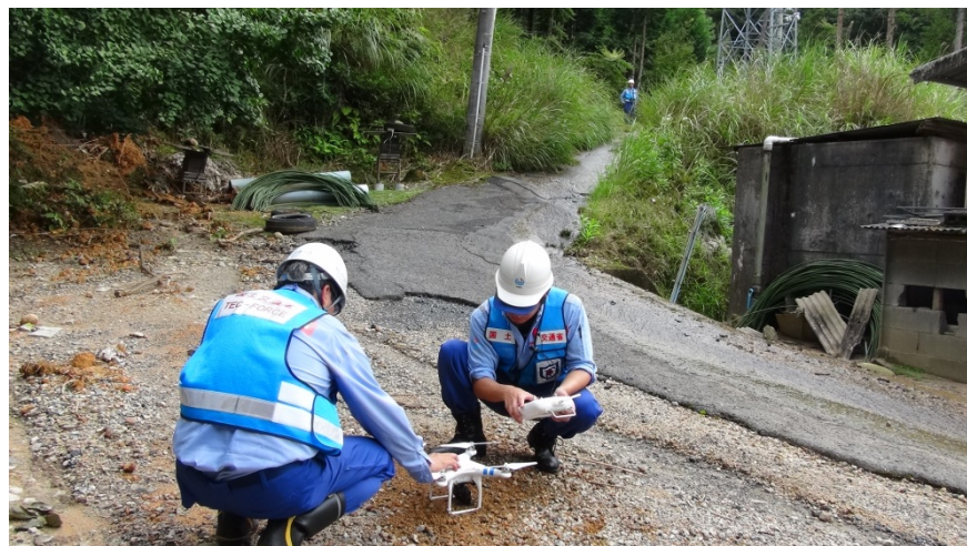
▲ マルチコプターの設置状況
