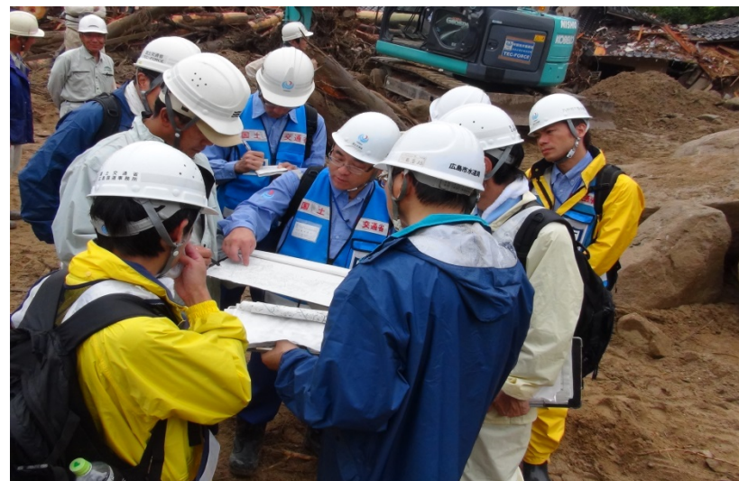
▲ 道路啓開の工法検討状況（緑井地区）
