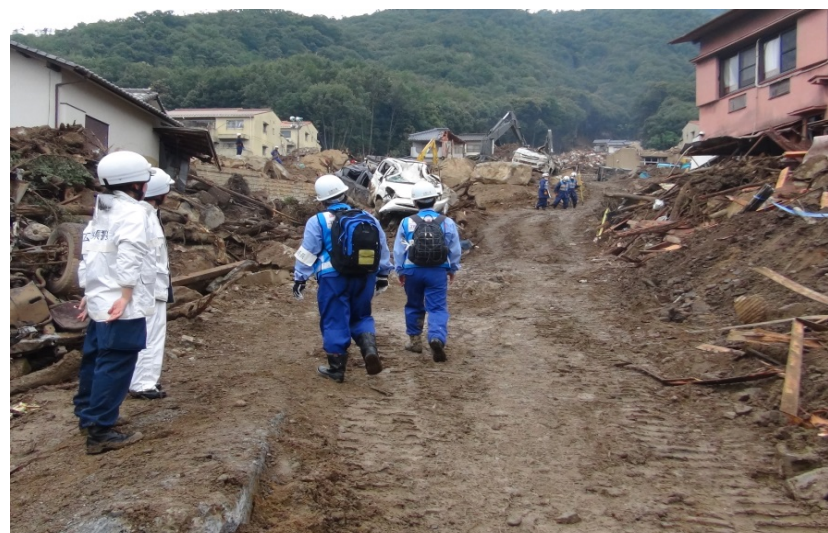
▲ 道路啓開調査状況（八木地区）
