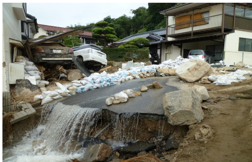
▲ 道路被災状況（緑井地区）
