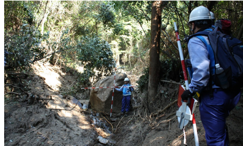
▲ 溪流の被災状況調査
