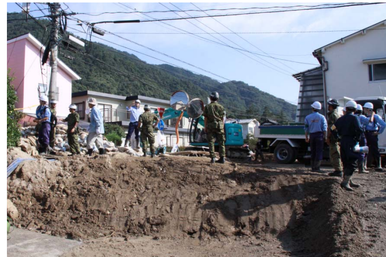
▲ 土砂撤去支援調査の状況(八木地区)
