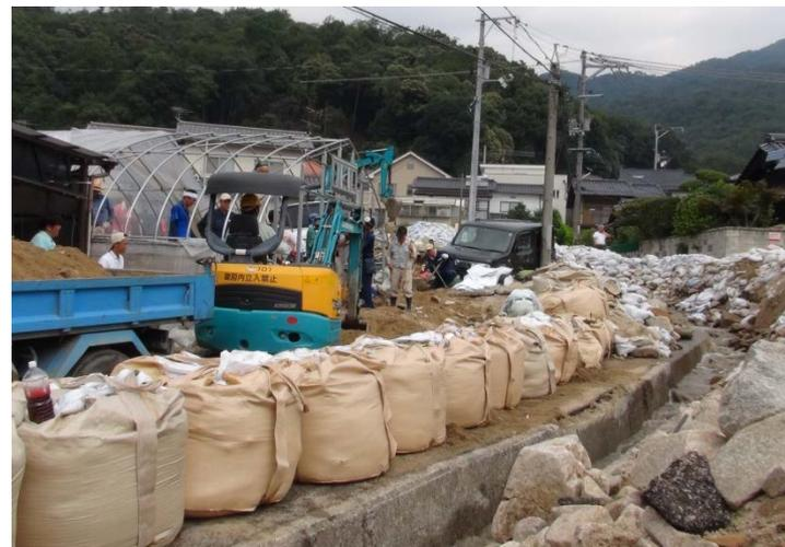
▲ 再度災害防止のため水路際に大型土のうを設置
