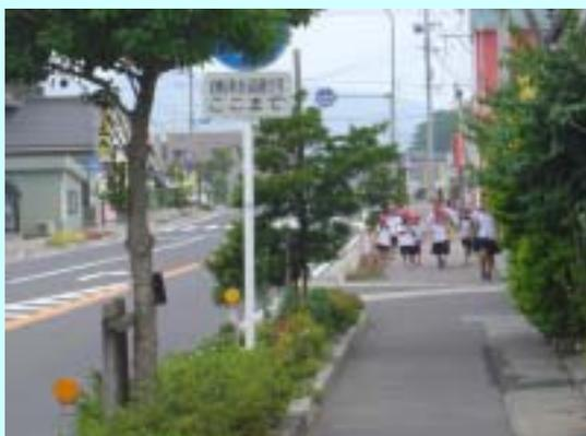
車道と歩行者自転車道の明確な分離により、車両と歩行者・自転車の接触機会の減少、視認性の確保などにより、車両のみならず、歩行者や自転車関連の事故(横断中、すれ違い接触)が減少することが期待される。
