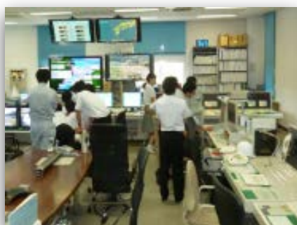
ダムの操作室
