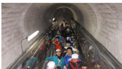
監査廊を通過してダムの中へ
