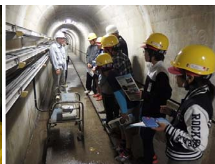
ダムの中(監査廊)
