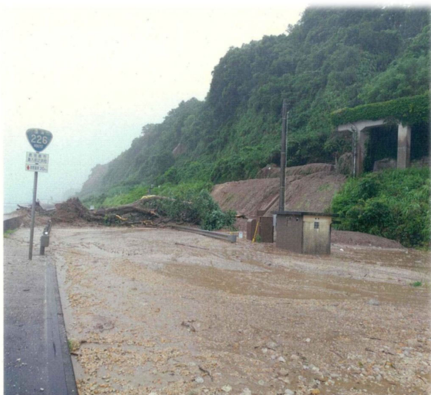
国道226号 鹿児島市喜入前之浜町～喜入町 6/21 05:30 右側斜面からの土砂流入により、通行止め
