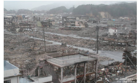
津波でこわれた建物
