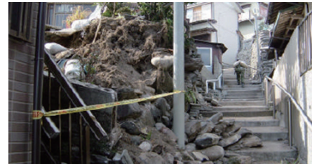
レンガや石積みがぐずれてこわれた塀 (写真：福岡市提供)
