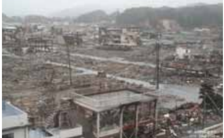
津波でこわれた建物
