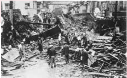
まち中に流れこんだ水でこわされた建物
