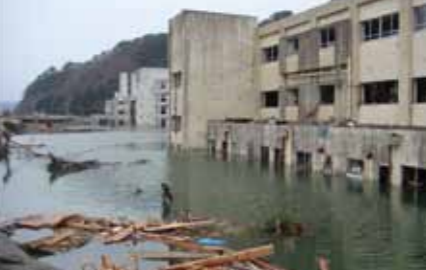
津波で水につかった学校の校舎 (写真：片田研究室提供)
