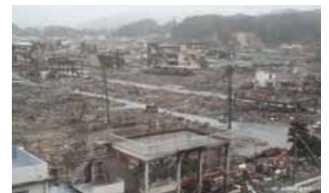
津波でこわれた建物
