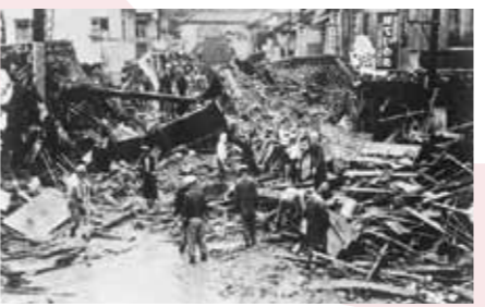
まち中に流れこんだ水でこわされた建物
