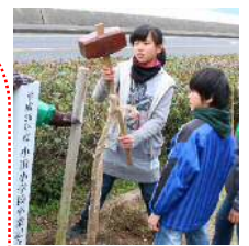
支柱を打ち込む
