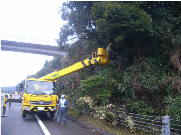
＜樹木伐採作業＞
