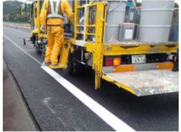
＜路面標示工事＞
