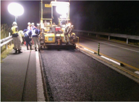
＜舗装補修工事＞
