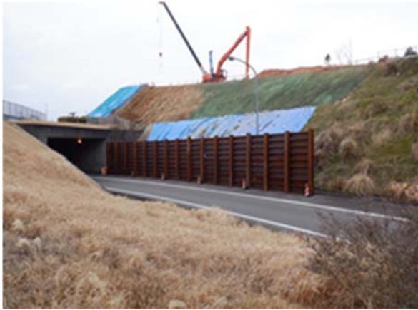
<のり面補修工事>
