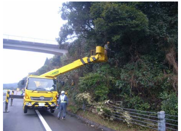
<樹木伐採作業>
