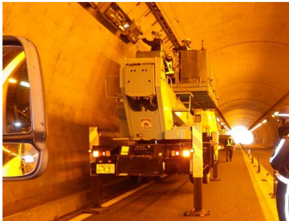
<トンネル照明灯具点検・取替工事>
