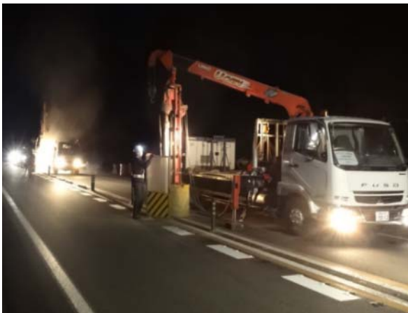
<ワイヤロープ設置工>
