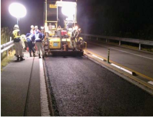
<舗装補修工事>
