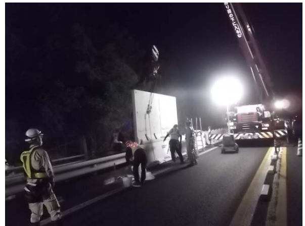
<4車線化工事 仮設防護柵設置>
