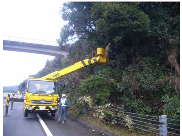
<樹木伐採作業>
