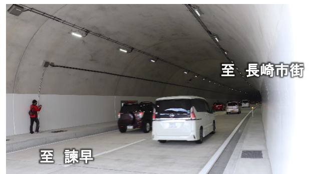
写真③ トンネル坑内(下り線)
