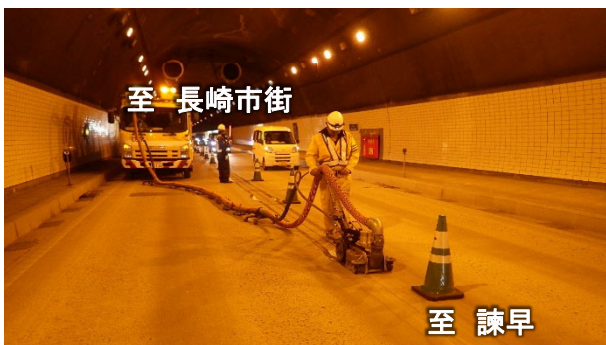
写真④ トンネル坑内(上り線) (中央線消去)
