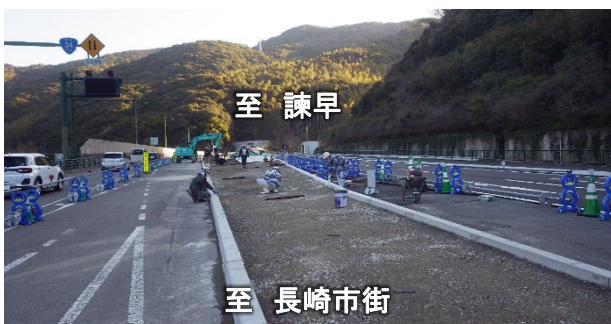
写真⑤ 奥山交差点 (中央分離帯設置)
