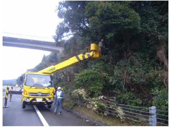
<樹木伐採作業>
