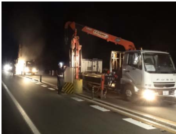
<ワイヤロープ設置工>
