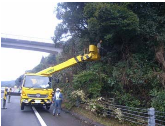
＜樹木伐採作業＞
