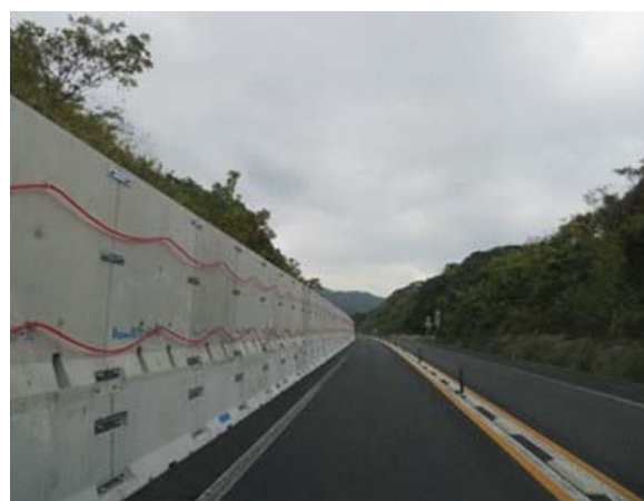
＜仮設防護柵設置＞
