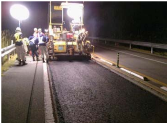
＜舗装補修工事＞
