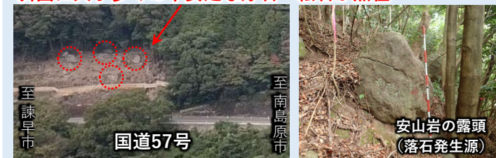
写真③ 国道57号の上空斜面に存在する浮石・転石
