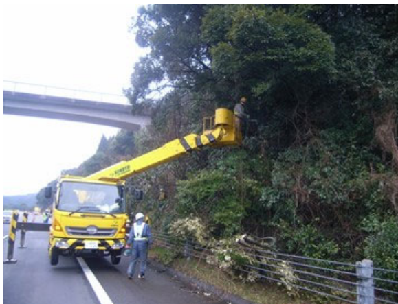
<樹木伐採作業>
