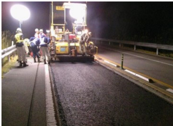
<舗装補修工事>
