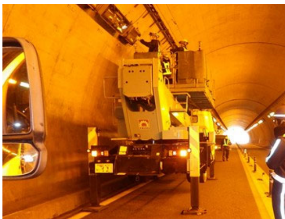
<トンネル照明灯具点検・取替工事>
