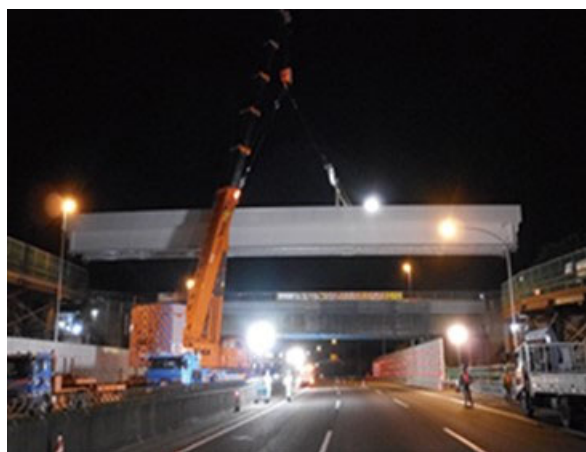
<橋梁桁架設>
