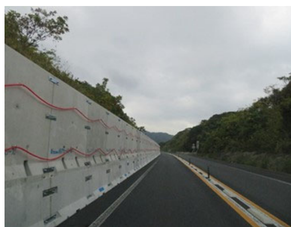
<仮設防護柵設置>
