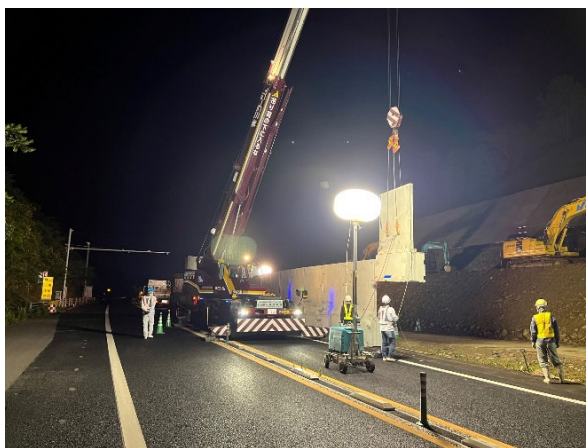
＜仮設防護柵設置＞
