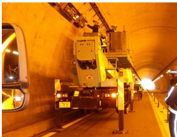
＜トンネル照明灯具点検・取替工事＞
