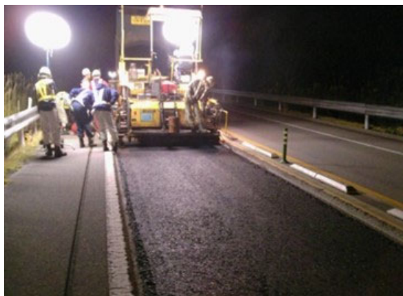
＜舗装補修工事＞
