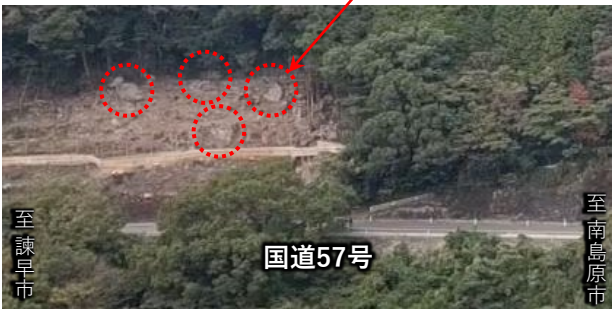
写真③ 国道57号の上空斜面に存在する浮石・転石
