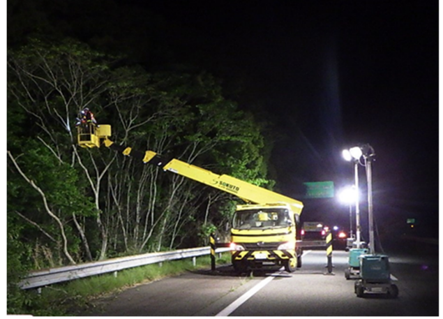
<樹木伐採作業>
