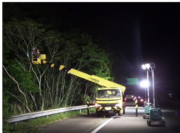
＜樹木伐採作業＞
