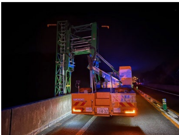
＜橋梁保全工事＞
