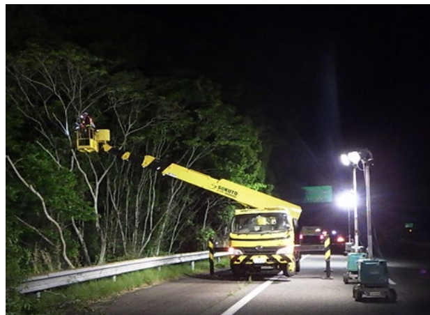
＜樹木伐採作業＞
