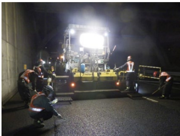
＜舗装補修工＞
