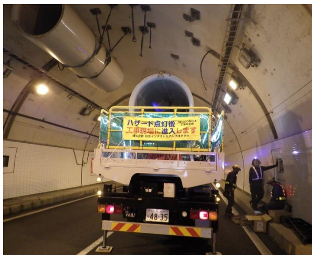
<トンネル換気設備撤去>
