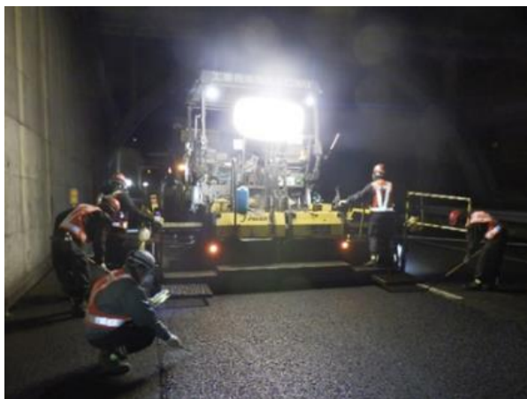
<舗装・路面標示工>
