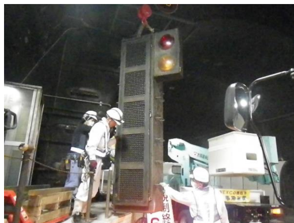
<路側設備撤去>
