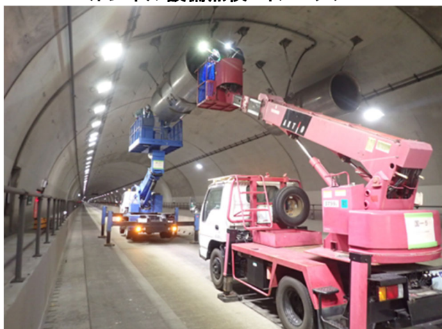
＜トンネル設備点検 イメージ＞
