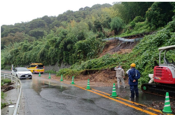
写真 法面崩落の状況 (松浦市御厨町、R5.9.15)
