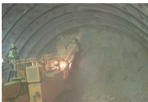
▲機械による掘削
