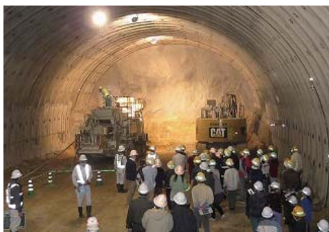
▲作業中の先端部を視察
