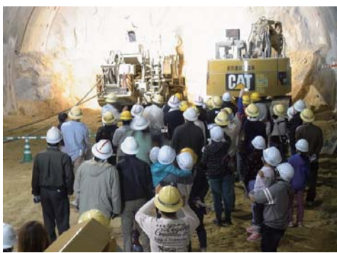
▲作業中の先端部を視察
