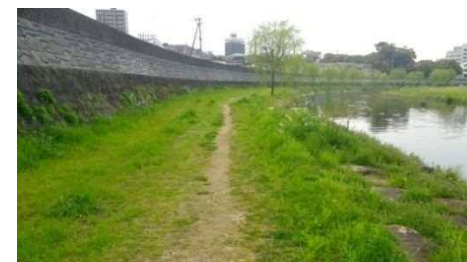
整備されていない管理用通路
