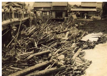
流木の堆積状況 (S32.7諫早大水害)
