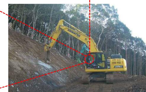
GPS搭載バックホウによる作業のため、工事測量や丁張り設置等の待ちなく施工でき、作業効率が向上する。
