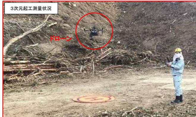
UAVを用いた3次元起工測量を実施することにより、測量の簡略化が可能となり、作業効率が向上する。
