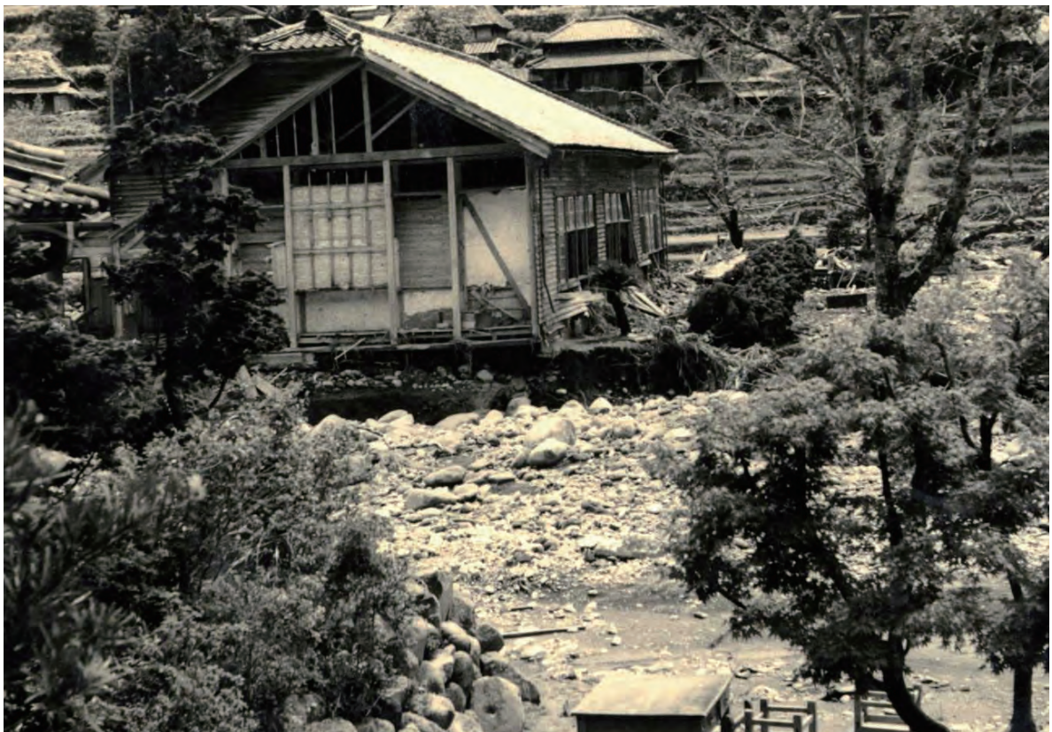
■校舎の半分が流された本野小学校（写真提供：諫早市）
