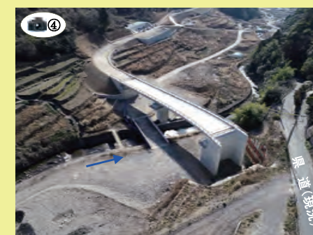
付替県道橋梁 上空から望む (R4. 2撮影)
