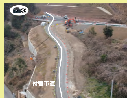
付替市道 上空から望む (R4. 4撮影)
